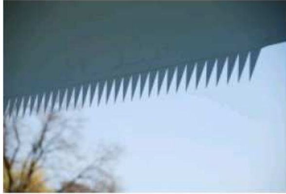
Figure 22 : Photographie d'une pale dotée d'un système TES (peigne / dentelure)
